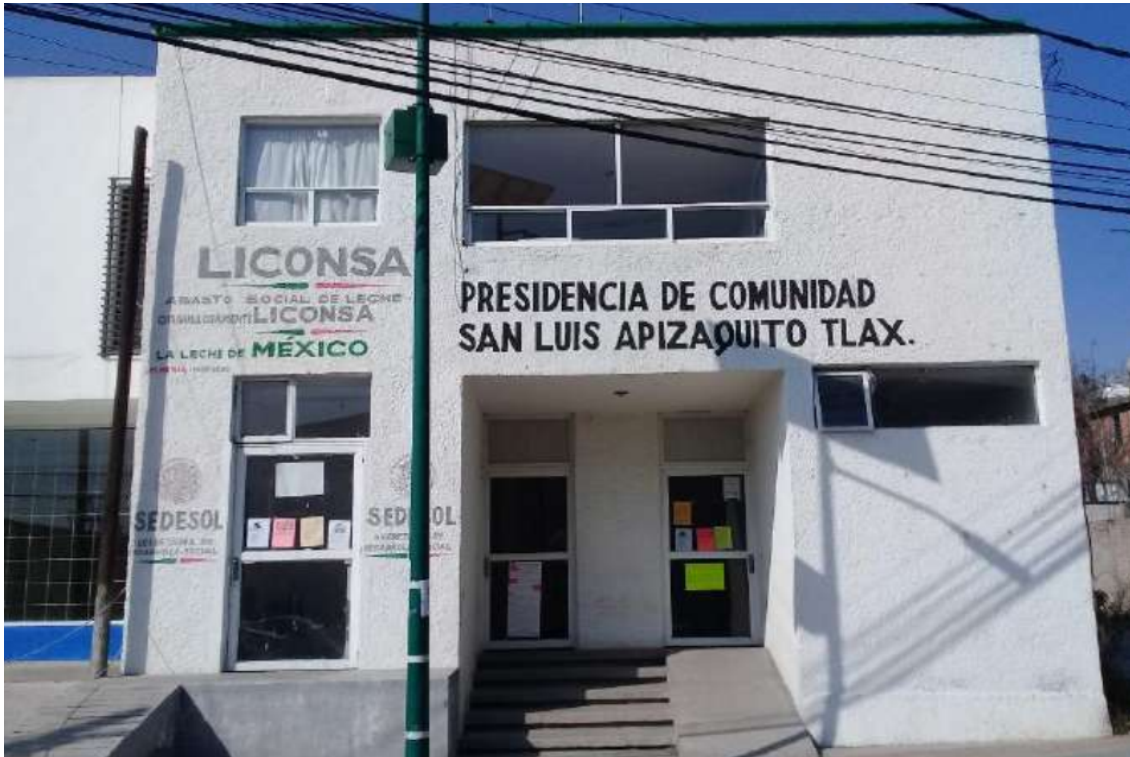
Figura 2. Fachada del entorno social considerado como estudio de caso.
