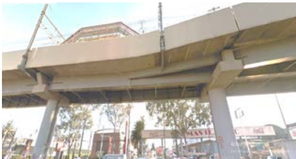
Fig. 9 Viga reconstruida (arriba) sobre las tres columnas verticales que se observan. Viga original (abajo) entre las dos columnas.
