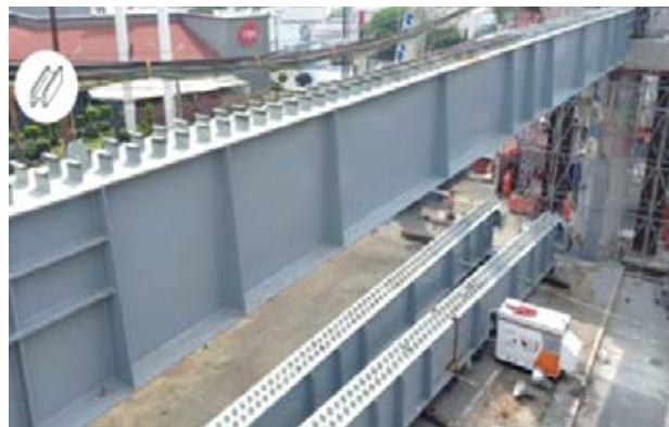
Fuente: SOBSECDMX, 2022 Fig. 8 Viga original (arriba), se usaron pernos Nelson. Viga reconstruida (abajo) se usaron 2 filas de ángulos.
