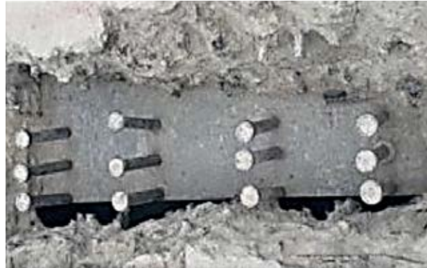
Fuente: DNV, 2021 Sección de la trabe con la totalidad de los pernos por diseño.
